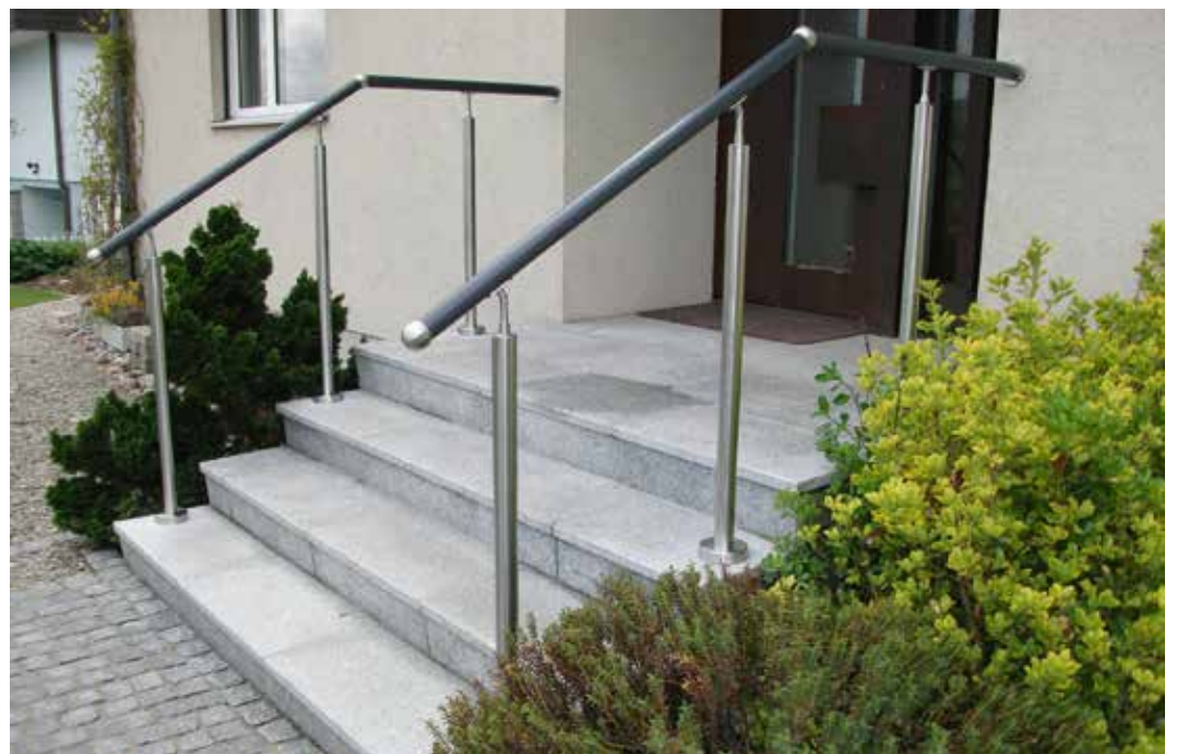
Beidseitiger Handlauf aus einem Aluminiumrohr ummantelt mit einem Laminat und aufgeschraubten Chromstahlstützen
