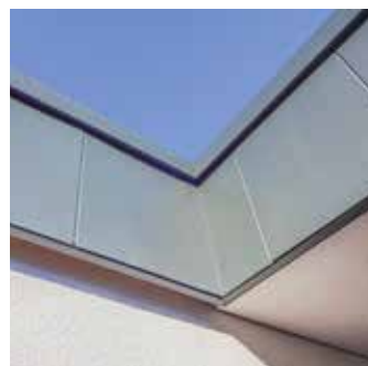
Bekleidung mit perfekten An- und Abschlüssen, links beim Schattenwurf die Luftzufuhr für die belüftete Dachdeckung
