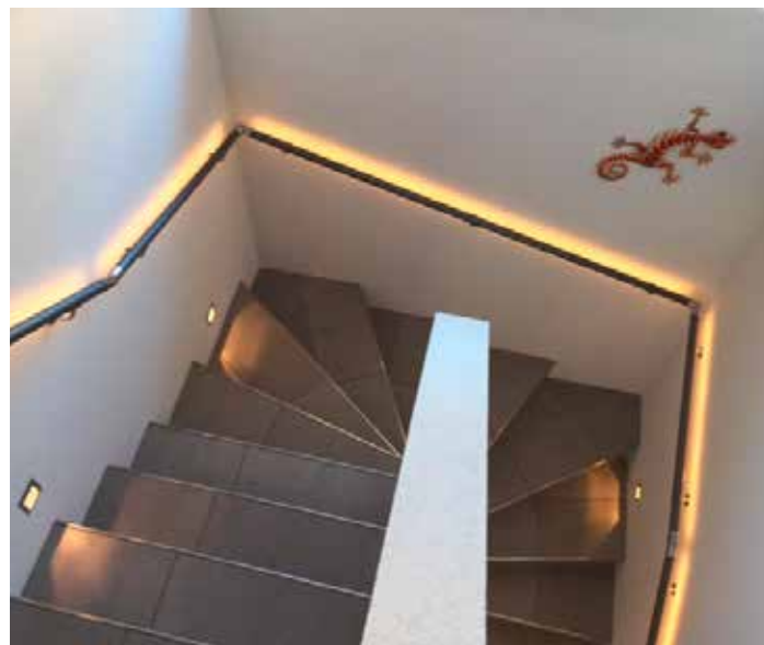
Wandseitiger Handlauf mit LED-Beleuchtung, elegant und sicher
