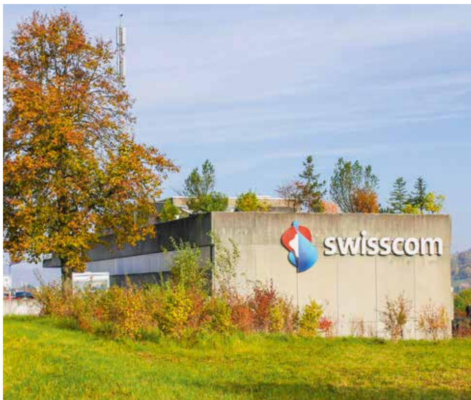
Die Online-Energiesparlösung NOL optimiert seit Beginn der Heizsaison mehrere Liegenschaften der Swisscom Immobilien AG – so auch dasjenige in Liestal.
