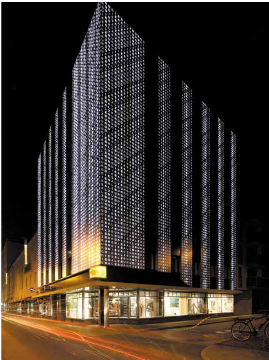
Augenweide auch nachts: Fassade mit leuchtenden Schriften (Bild: Gasser Fassadentechnik AG).
