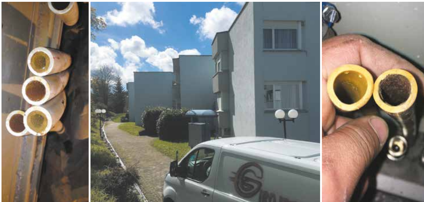
Bild links: Durch Installateur verursachte Totalverschlüsse bei Spülversuch. Bild Mitte: Überbaugung in Zürich im Girojet-Verfahren gereinigt. Bild rechts: Bodenheizungsrohre ohne vor und nach der Reinigung.
