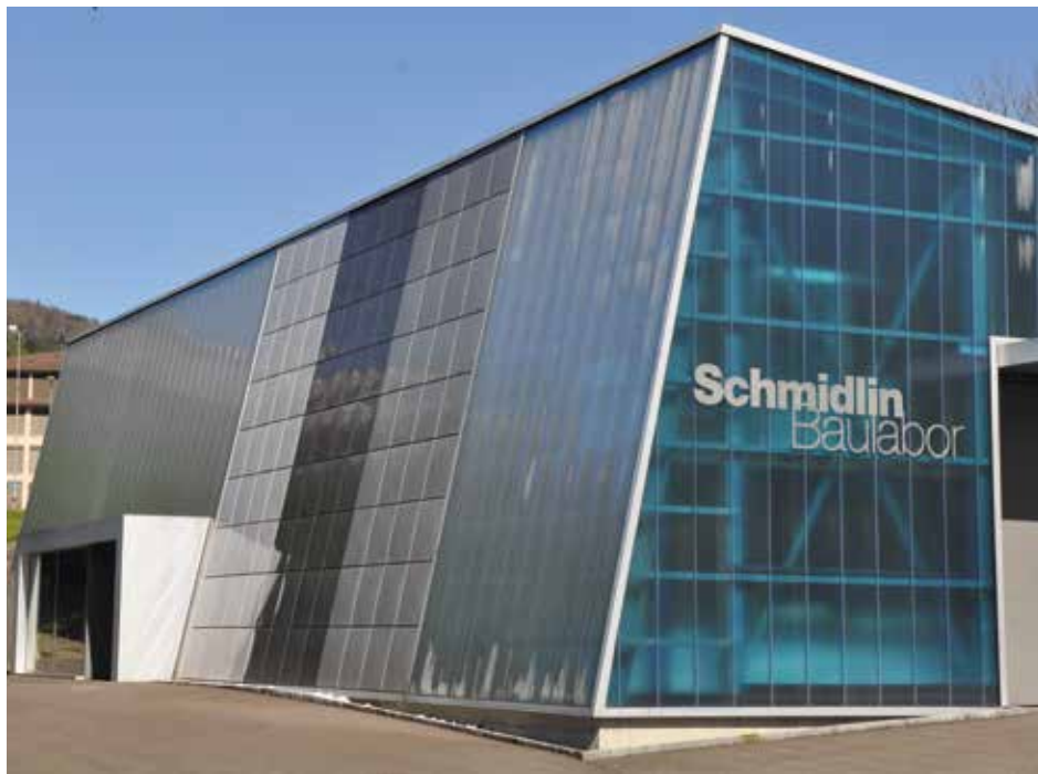
Langzeitversuch an der Gebäudehülle des Baulabors der Schmidlin AG in Oberarth.
