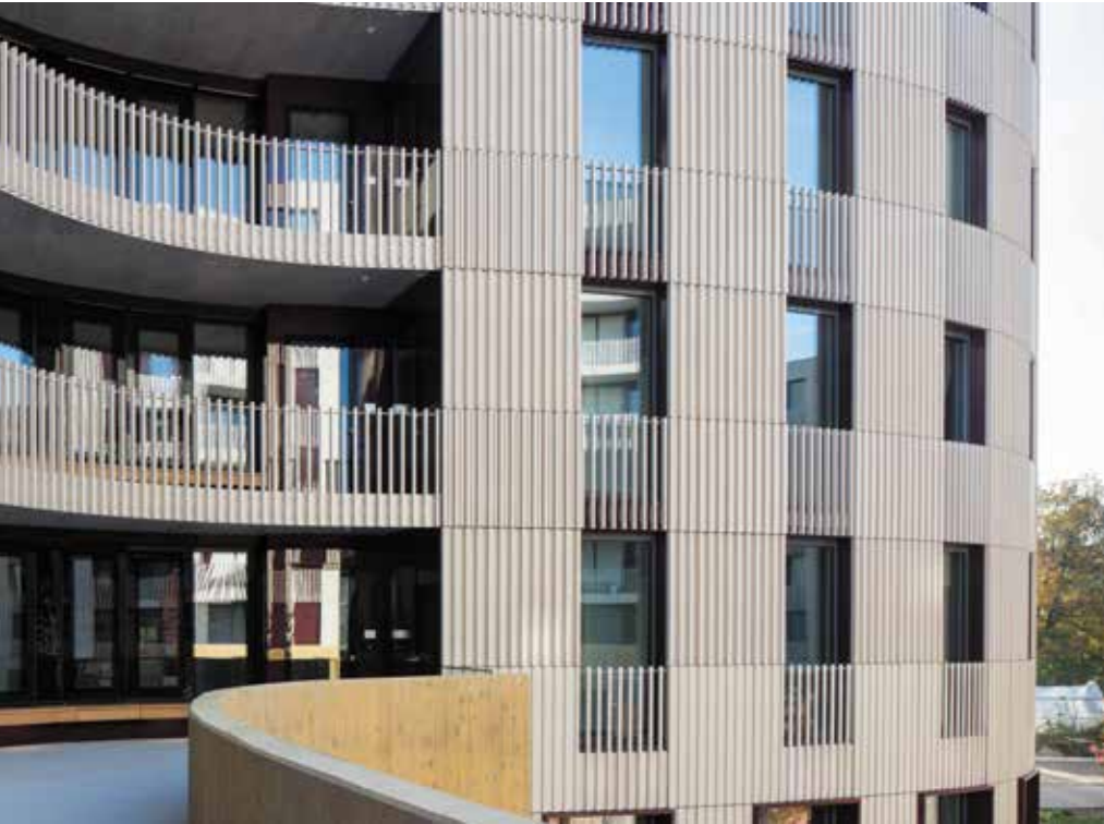
Drei Neubauten mit Studentenwohnungen auf dem Höggerberg der ETH Zürich mit einer reliefartig profilierten, hinterlüfteten Keramikfassade von Gasser Fassadentechnik.
