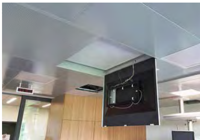
Kontroll- und Service-Arbeiten von unten aus dem Raum
