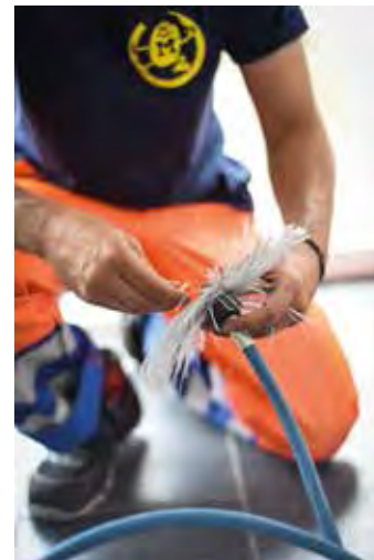
Die RohrMax-Monteure Lüftungsreinigung sind alle zertifiziert nach SWKI-VA104.
