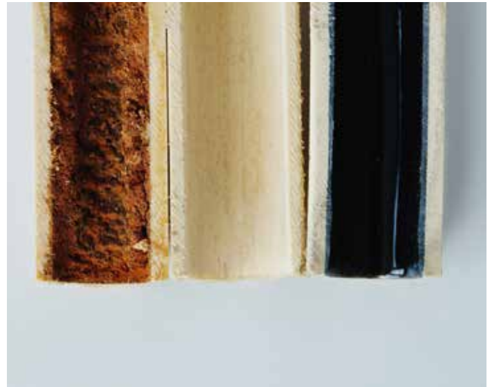
Bodenheizungsrohr: Vor, während und nach der Sanierung mit dem originalen HAT-System.
