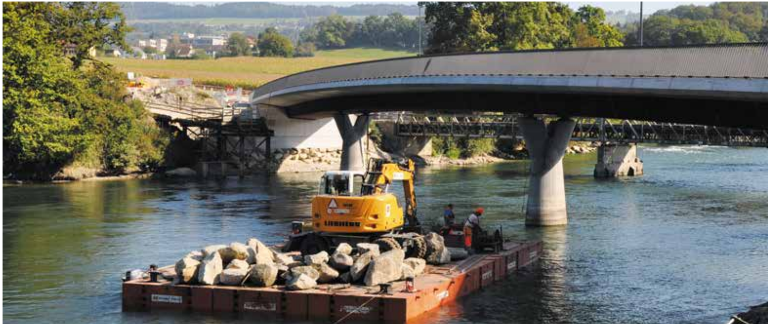
Der Neubau der Brücke erfolgte neben der inzwischen zurückgebauten alten (im Hintergrund).
