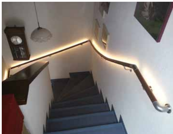
durchlaufender Handlauf mit Licht, wandseitig, wo die Stufen breiter und sicherer sind
