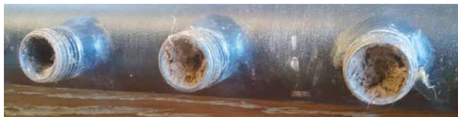
Das «Microclean» – Verfahren ermöglicht eine Tiefenreinigung der verschlammten Rohre ab der Heizzentrale, ohne dass dafür bauliche Massnahmen notwendig sind.
