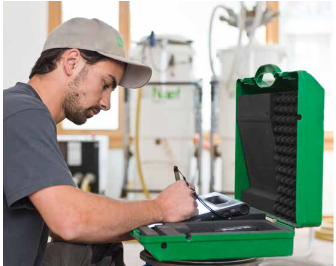
Seit 1985 kümmern sich die Mitarbeitenden der Naef GROUP täglich um die nachhaltige Sanierung wasserführender Leitungen im Gebäude.
