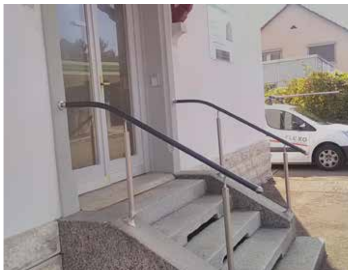
Beidseitiger Aussenhandlauf vor einem Bürogebäude
