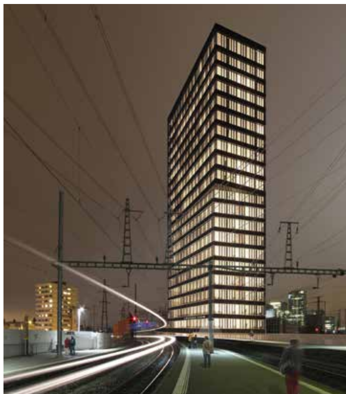
Der 80 Meter hohe Andreasturm beim Bahnhof Zürich Oerlikon ist direkt mit dem Bahnhof verbunden und bietet eine ideale Anbindung an den öffentlichen Verkehr. Bild: SBB Immobilien.
