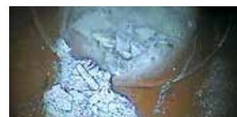
Bei Neubauten und nach Renovationen: Ablaufprobleme durch Baurückstände in den Abwasserrohren
