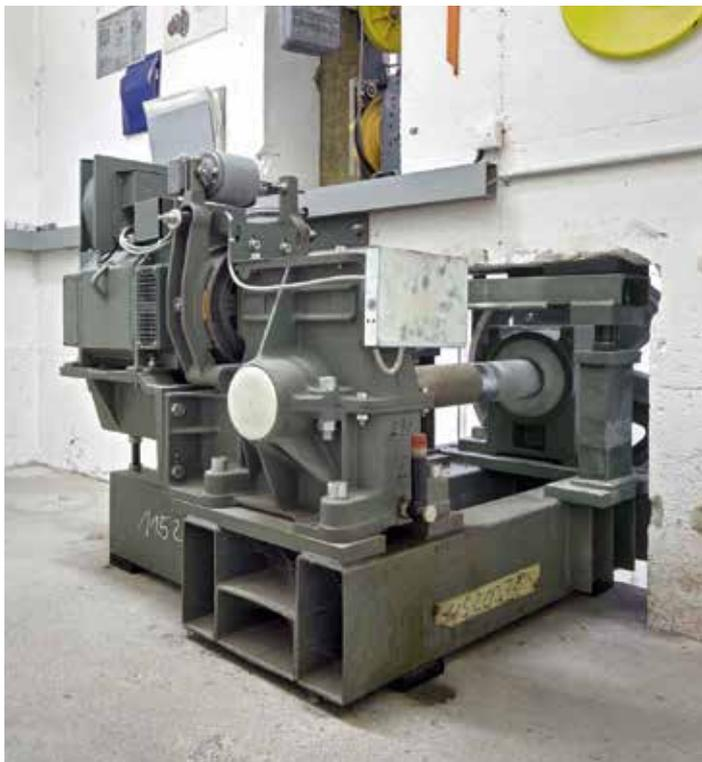
Das Bild zeigt einen Maschinenraum mit einem Aufzugsantrieb neuester Generation – Der neue Motor verbessert den Energieverbrauch eines Aufzuges entscheidend und macht den Betrieb sicherer.
