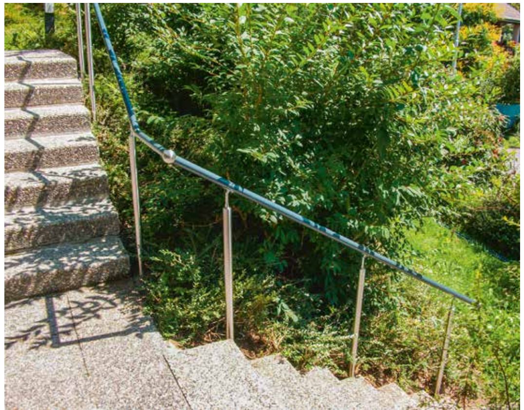
Aussenhandlauf mit einbetonierten Stützen
