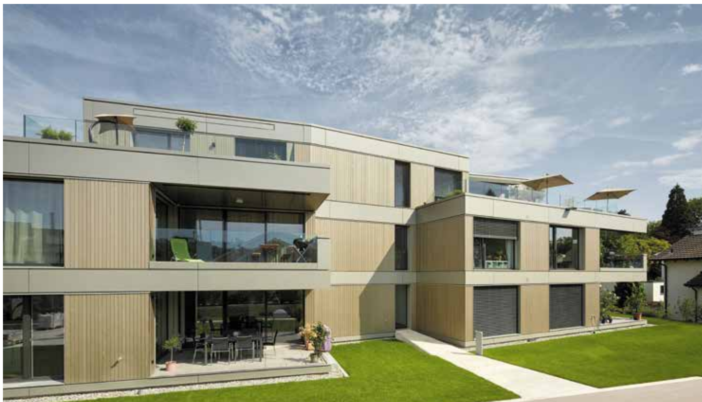
Von aussen nicht sichtbar: Das Mehrfamilienhaus ist ein reiner Holzbau, sogar der Liftschacht ist aus Holz.
