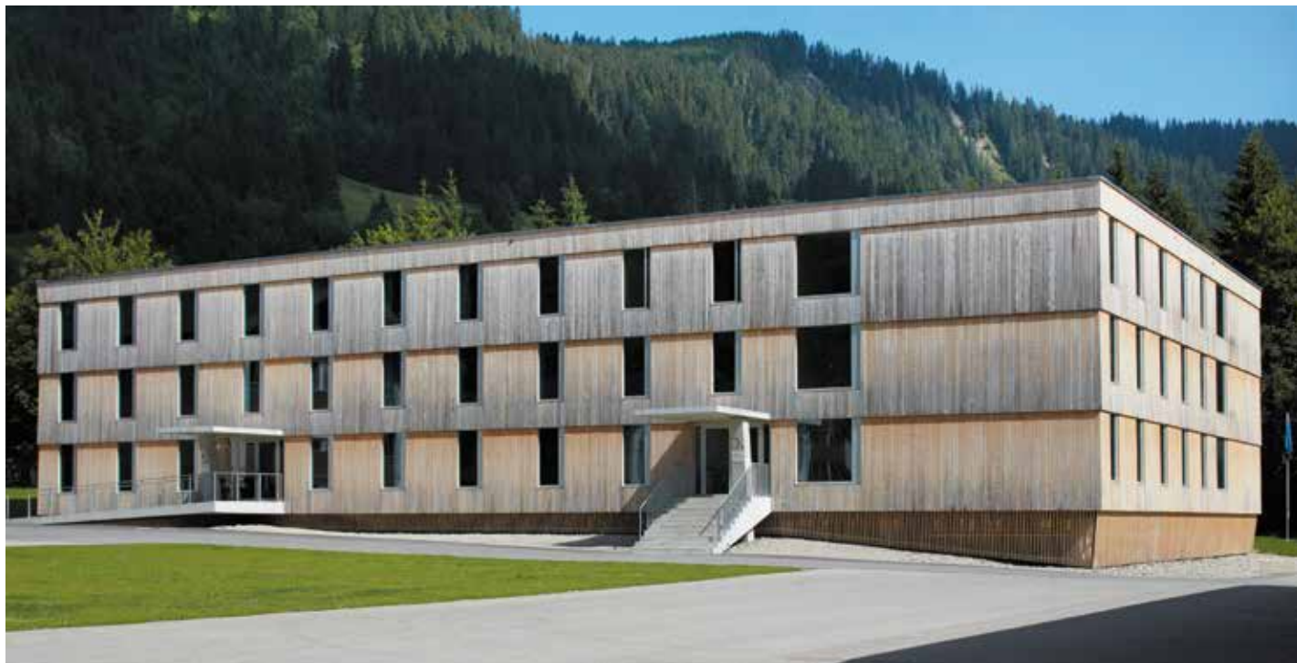
Blick auf einen der beiden Zwillinge in Holz: schlichtes, aber funktionales Holzgebäude mit geschossweise gestülpter Fassade aus vertikalen Weisstannenbrettern.
