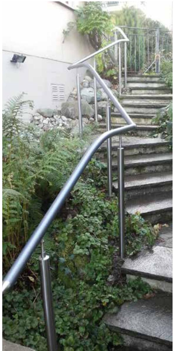
Durchlaufender Handlauf an einer nicht einfachen Treppenanlage
