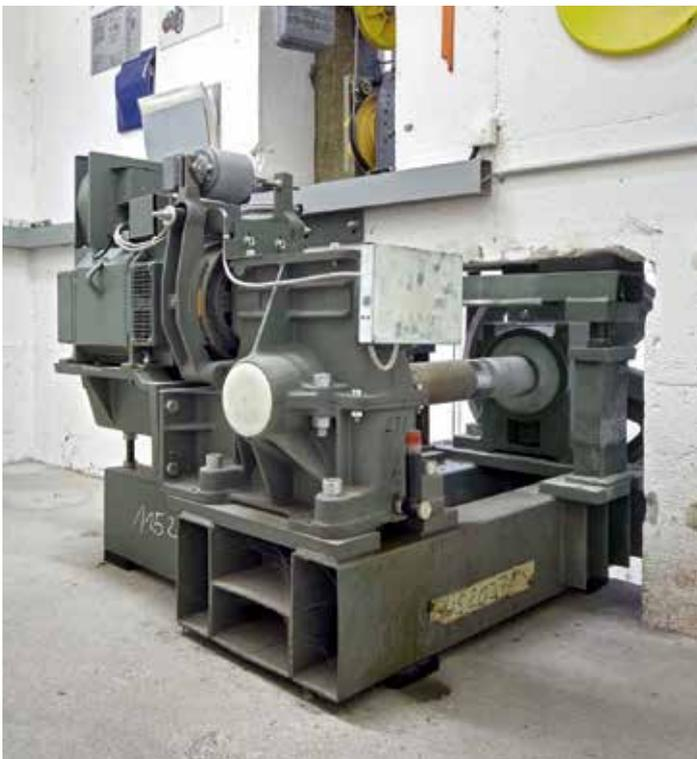
So sahen der in die Jahre gekommene Aufzugsantrieb und die Steuerung des Aufzuges vor dem Umbau aus.
