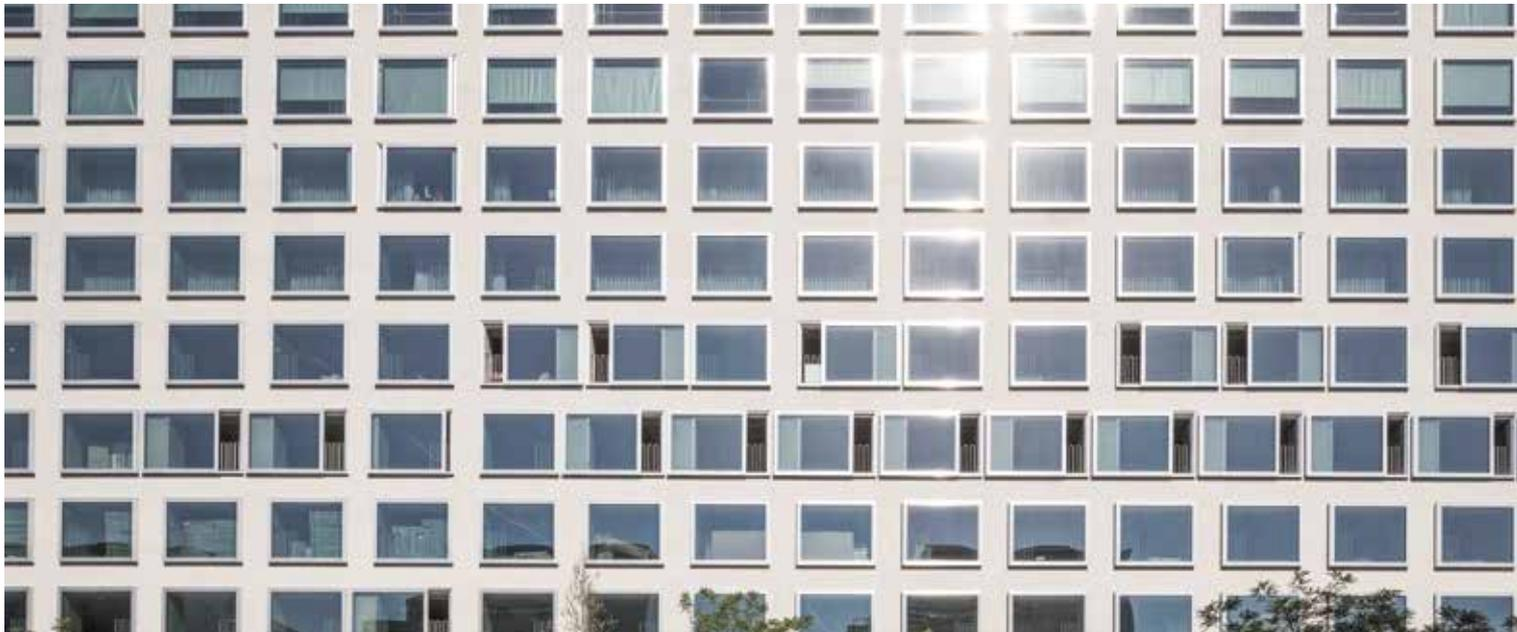
500 identische air-lux Fenster wurden wie Bilderrahmen auf die Fassade aufgesetzt und prägen damit den Ausdruck des Gebäudes (Fotos: Daniel Ammann).
