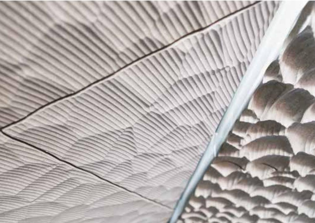
Zwischen den Elementen wurden Fugenbänder eingebaut und die einzelnen Fugen nach der Montage zusätzlich mit Silikon ausgefüllt.
