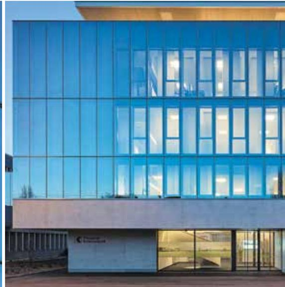
Glaskubus zu schaffen, beschritt Aepli Metallbau, Gossau, bei der Konstruktion der Fassade bewährte Wege. Und entschied sich für den Einsatz konventioneller Doppelhautfassaden.
