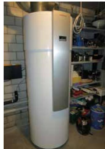
Trinkwasser-Wärmepumpe mit hervorragendem COP von 3,6.
