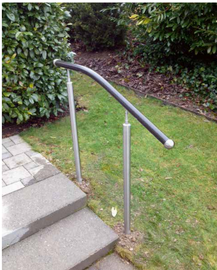
2 Stufen mit betonierten Stützen
