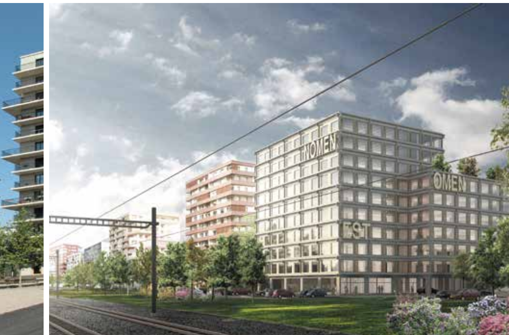
Der Bau des ersten Holzhochhauses in der Schweiz hat im August 2016 in Risch-Rotkreuz begonnen (Bild: Zug Estates AG).
