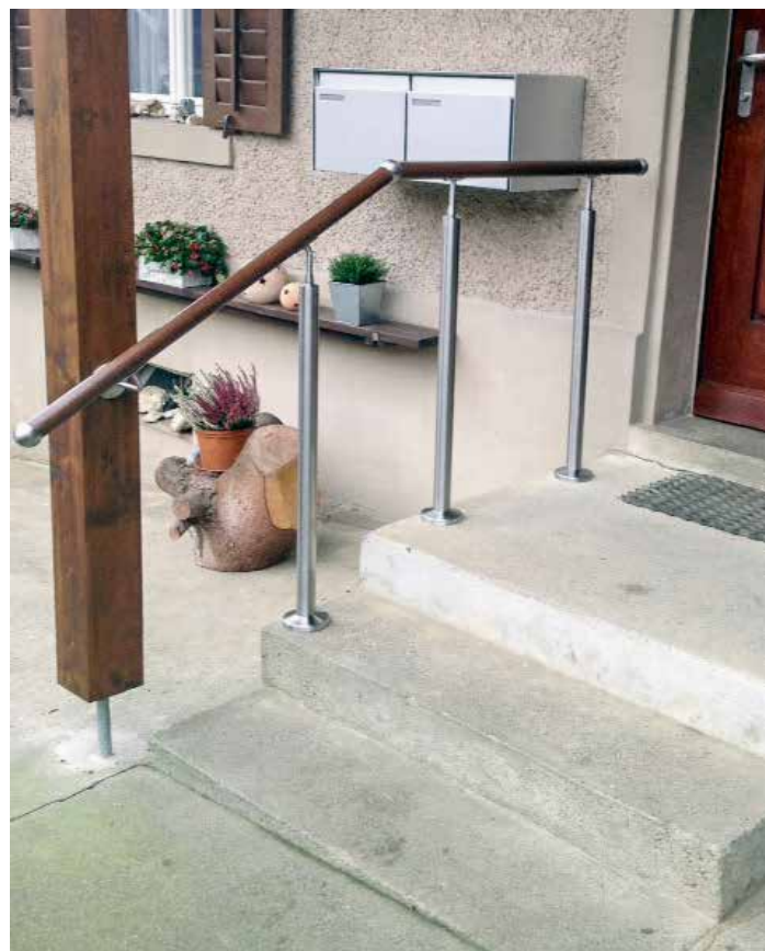
Aluminiumhandlauf ummantelt mit einem Laminat
