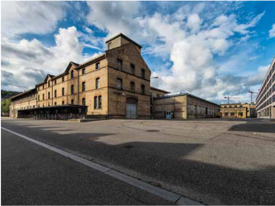
Werk 1 Winterthur (Bild: Implenia).
