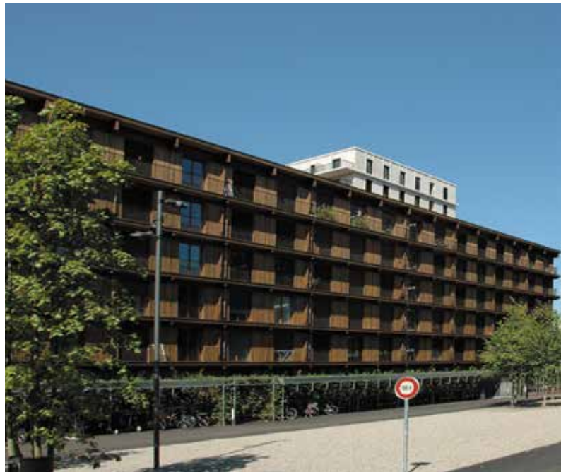
Auf dem Freilager-Areal in Zürich wurden über 1000 Wohneinheiten erstellt – 187 Wohnungen in Holzbauweise (Bild: Michael Meuter).
