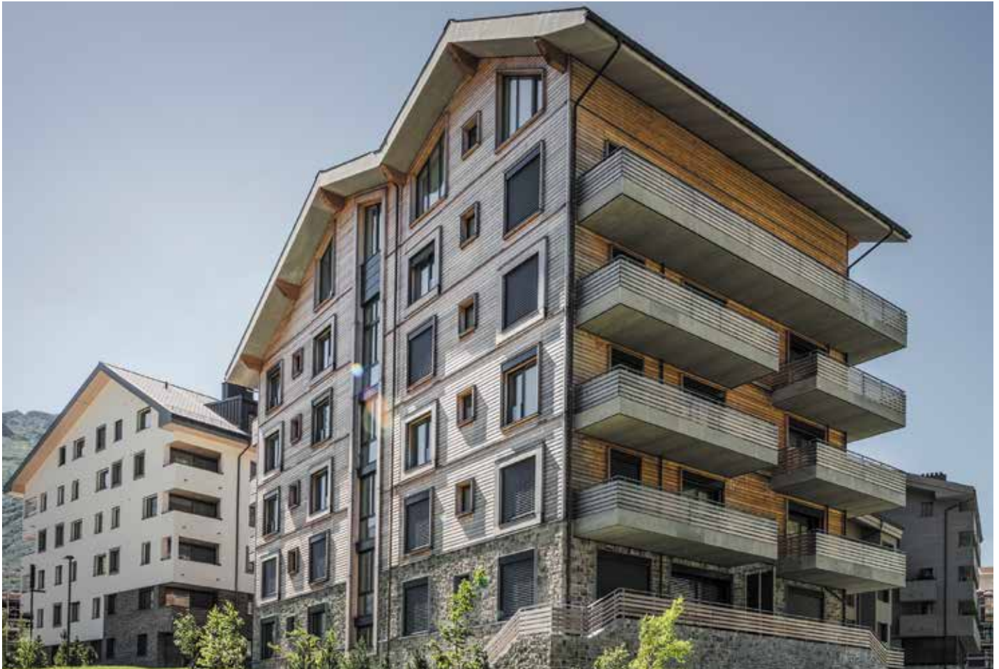
Projekt der Andermatt Swiss Alps AG: Aussenansicht der Apartmenthäuser Gemse (Vordergrund) und Biber (Hintergrund).
