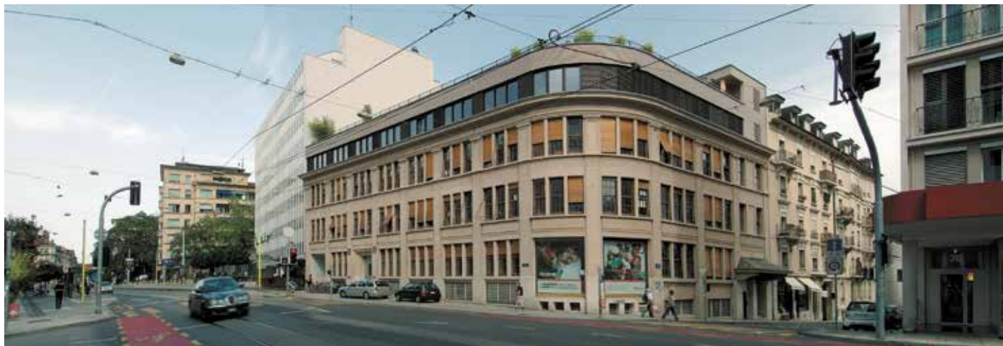
Genf: Aufstockung «Médecins Sans Frontières», 2007. Architekt: Jean-Pierre Golinelli, Genf (Foto: Corinne Cuendet, Clarens/Lignum).
