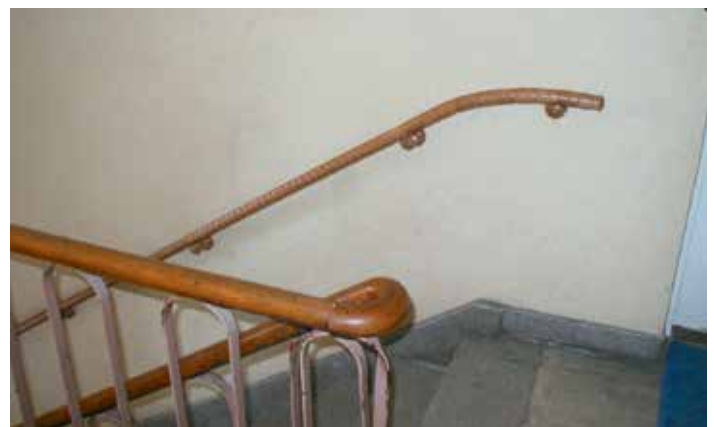
Nachgerüstet mit einem griffigen Holzhandlauf
