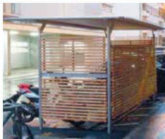
Ausführung mit Wänden aus Holzlamellen
