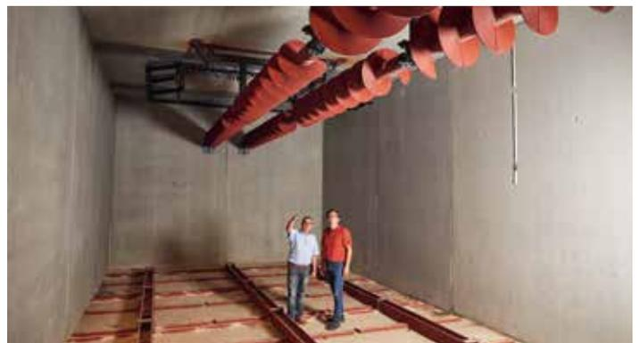
Komfortable Lösung: Dank des Schubbodens und der Förderschnecken gelangen die Holzschnitzel vom Bunker automatisch zu den beiden Heizkesseln.
