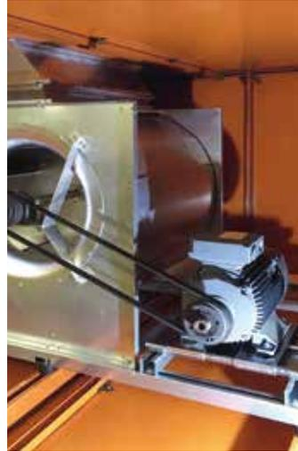
Bild 2: Kompl. neue Ventibaugruppe im Hemair-Gerät
