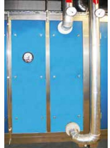
Bild 3: Fläkt-MBL: Neuer Kühler und neue Gehäuseteile, welche den Originalwänden in nichts nachstehen
