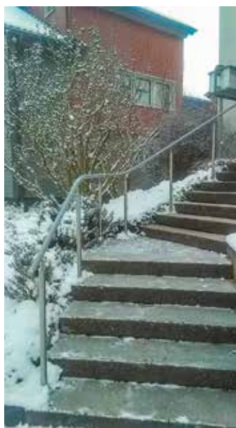
Aluminium-Handlauf mit handwarmen Laminat
