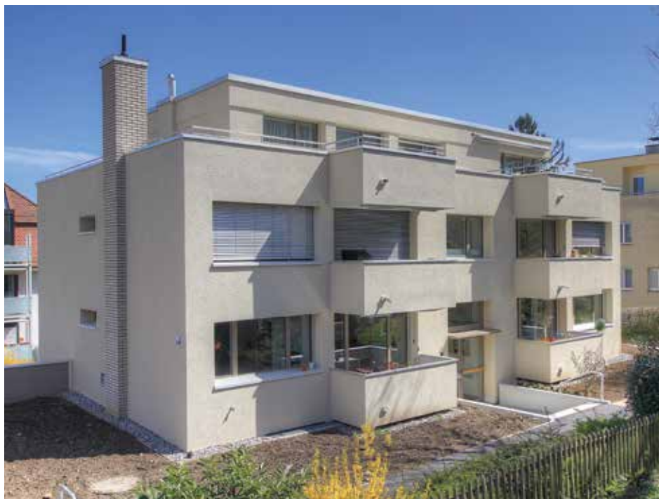
Das Mehrfamilienhaus am Schützenrain in Zürich wurde einer Gesamtsanierung unterzogen.
