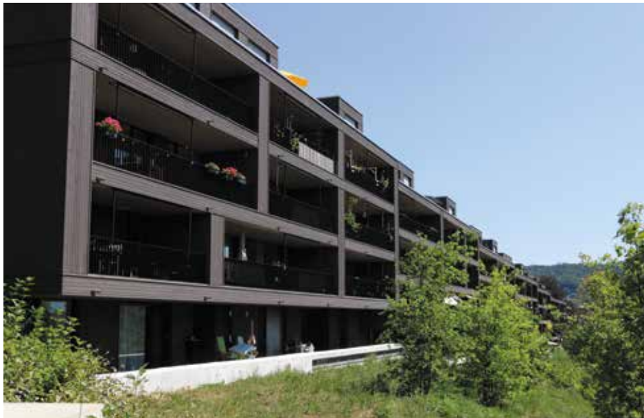
Die Photovoltaikanlage auf dem Dach nutzt das gesamte Solarstrompotenzial (Bild: EWZ Zürich).
