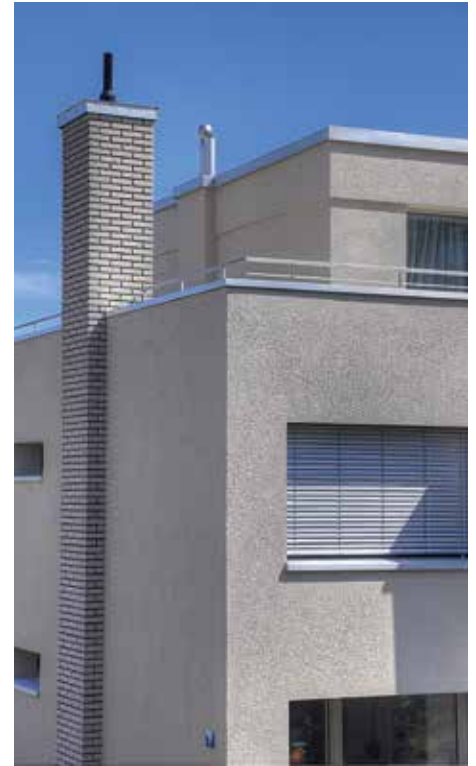
Die neue Kompaktfassade verleiht dem Haus aus den Sechzigerjahren ein zeitgemässes Erscheinungsbild.
