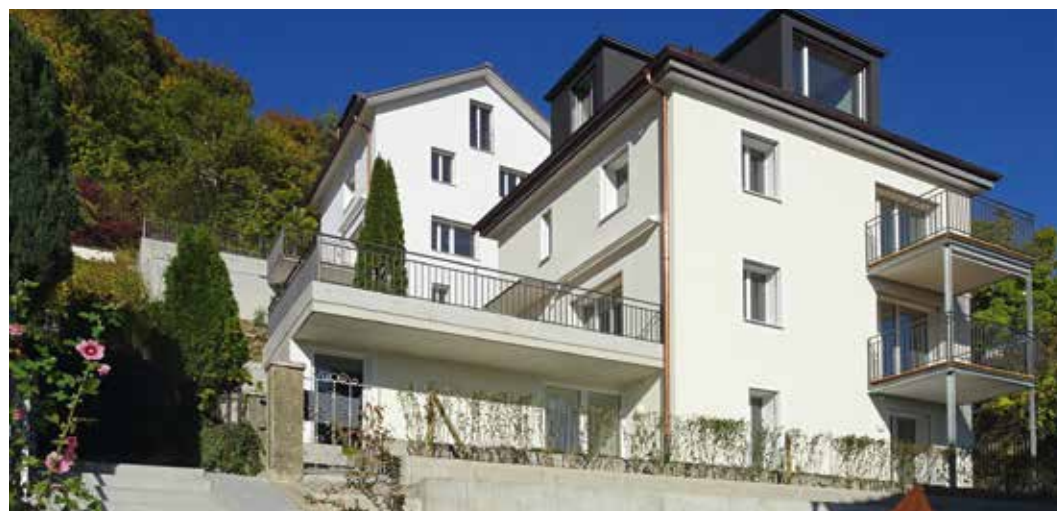
Nachher: «Das Einfamilienhaus in Ennetbaden ist eines der zwei ersten Gebäude, welches nach der Minergie Systemerneuerung zertifiziert ist. Das Gebäude ist nach «System 3» modernisiert.
