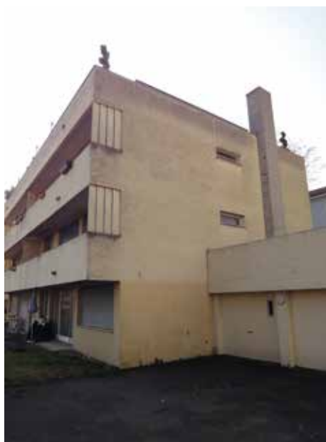
Die Fassade vor der Sanierung...
