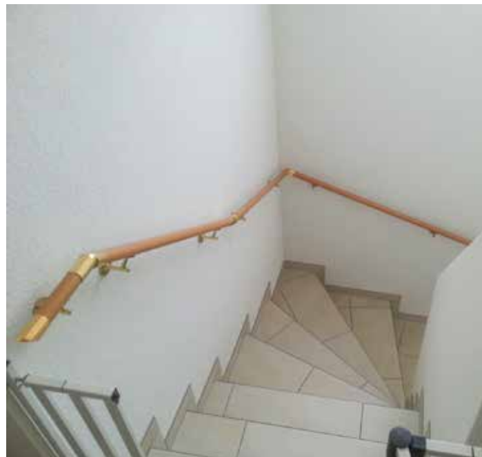
Handlauf in Buche, wandseitig, wo die Stufen breiter und damit sicherer sind
