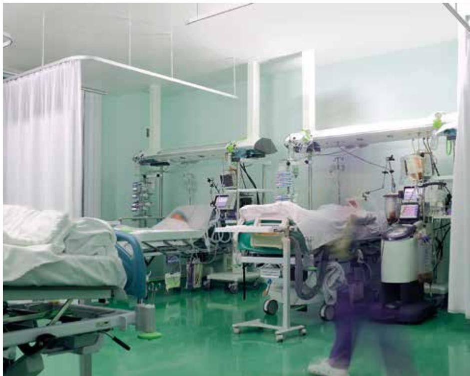
Keine stickige Luft im Bettenbereich dank Absaugung der erwärmten Luft oberhalb der medizintechnischen Geräte.
