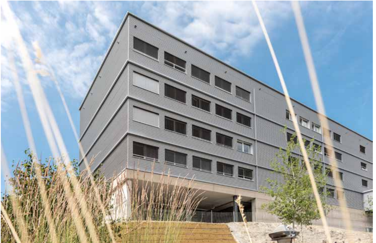
Trotz Massivmodulbau wurde eine hohe Komplexität erreicht: Inselspital, Bern.
