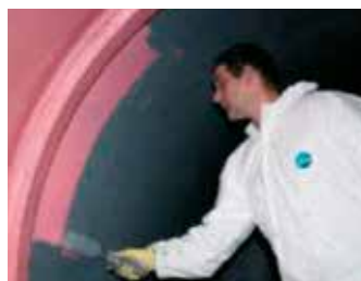
Stahltanks werden mit einer neuen Beschichtung versehen.
