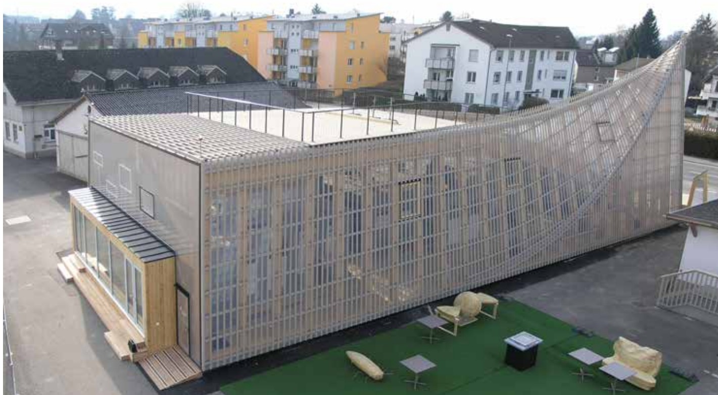
Pavillon Innovationspark Dübendorf mit Aussichtsplattform: Anlaufstelle und Treffpunkt für Wirtschaft, Investoren, Dienstleister und private Besucher (Bild: Blumer-Lehmann AG, Gossau).
