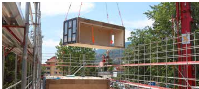
Werden serienmässig viele modulare Einheiten vorgefertigt, kann der Modulbau sein ganzes Potential ausspielen.
