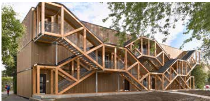
Modulbau Schulhaus Champagne in Biel mit aussen vorgesetzter Treppenanlage.
