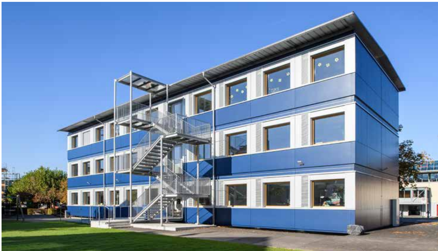
Schulraumprovisorium in Baar: Nach wenigen Monaten Planungs- und Bauzeit war die dreigeschossige Temporärbaute pünktlich zum Schulbeginn 2017 bezugsbereit (Bild: Blumer-Lehmann AG, Gossau).
