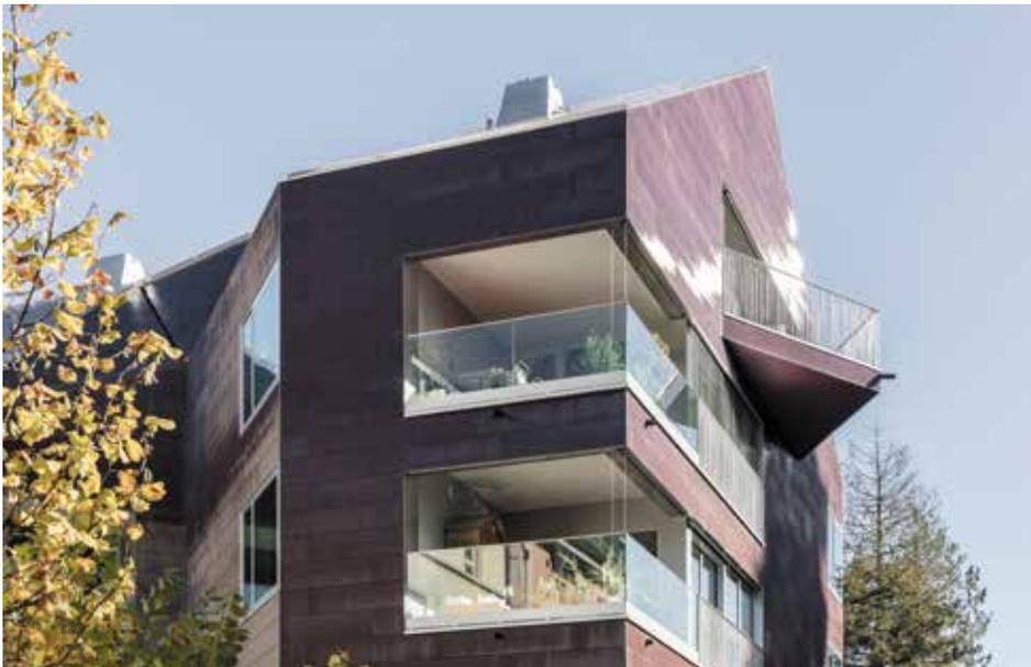
Das Mehrfamilienhaus «Solaris» ist allseitig mit PV-Modulen umhüllt und produziert 50 000 kWh Strom pro Jahr.
