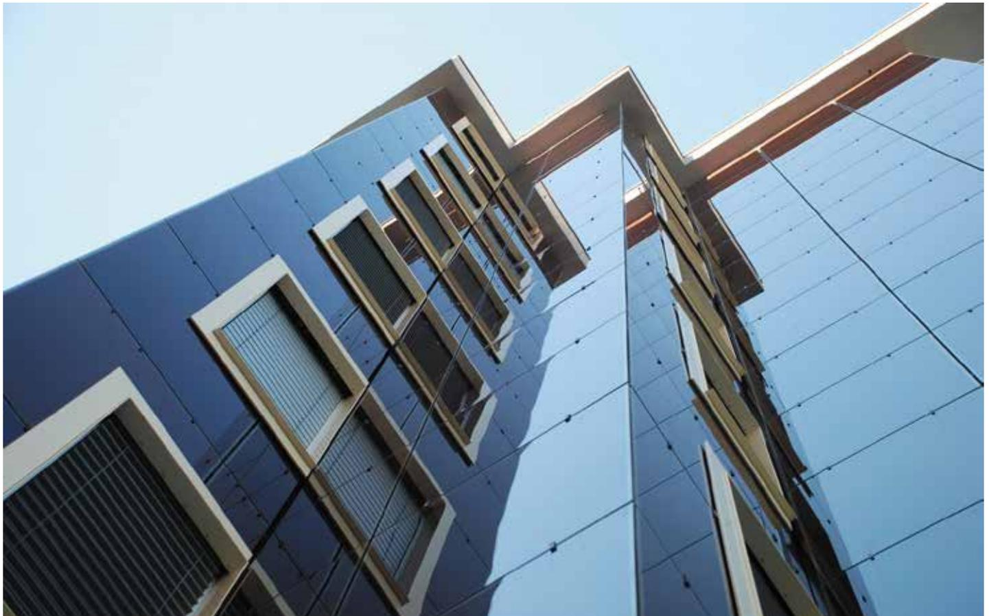
Schützt vor Wärmeverlusten, der Witterung und produziert auch noch Elektrizität: die Fassade von heute (Bild: GFT Fassaden AG).
