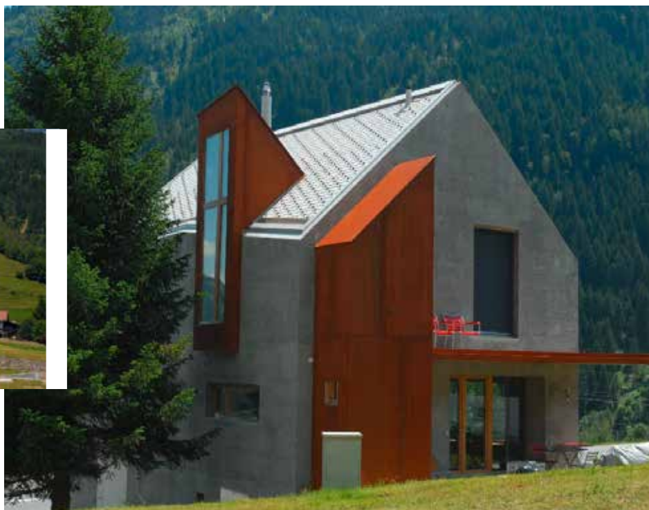
Das fünfeckige Haus hat gegossene, monolithische Aussenwände aus Dämmbeton. (BILD: ZVG)
