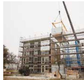
**Vorgefertigte Module aus Holz, ein Stahltragwerk, die Montage in wenigen Tagen – mit diesem neuen und innovativen System entsteht in kurzer Zeit ein nachhaltiges Mehrfamilienhaus mit 20 Mietwohnungen.**
