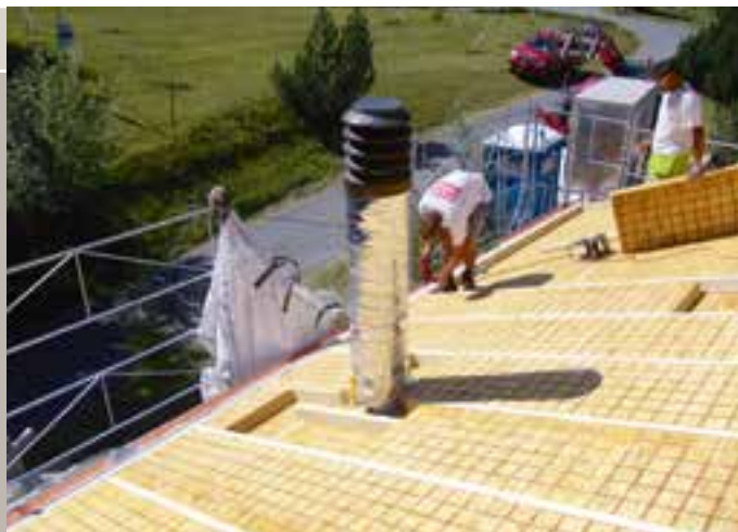
Das Dach eines Gebäudes wird mit einer Wärmedämmung saniert.
