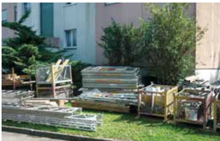
Das Mehrfamilienhaus vor der Renovation mit dem ursprünglichen Fassadenverputz und den alten Holzfenster aus den 1970er Jahren.
