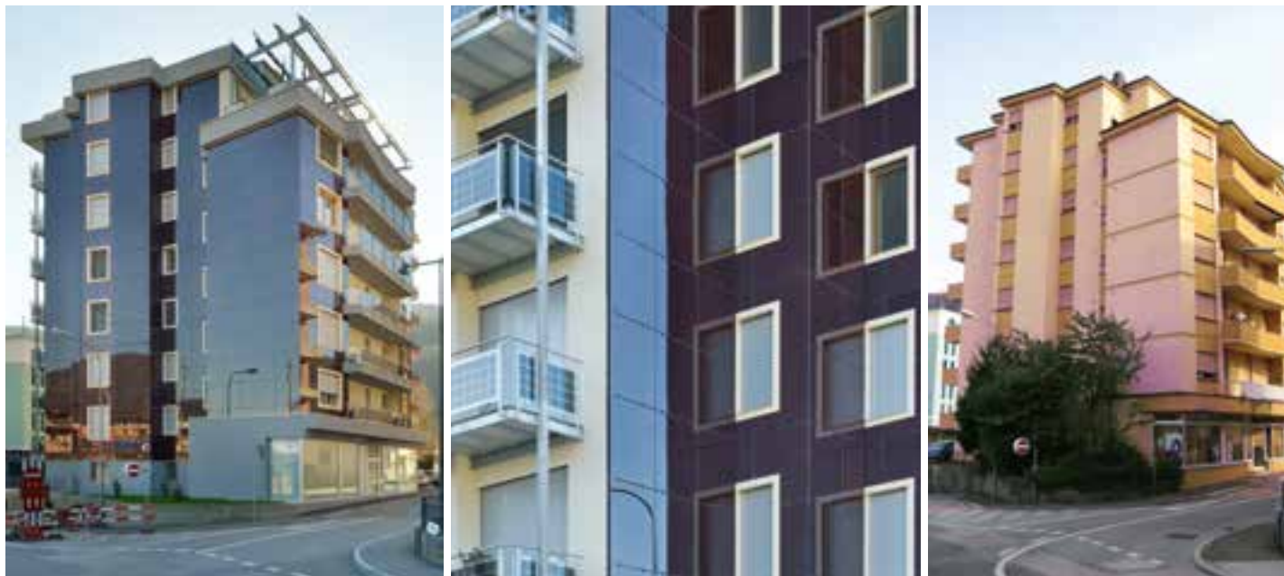
Nach der Sanierung mit Fotovoltaikmodulen produziert das Mehrfamilienhaus einen Energieüberschuss von 5000 kWh/a.
