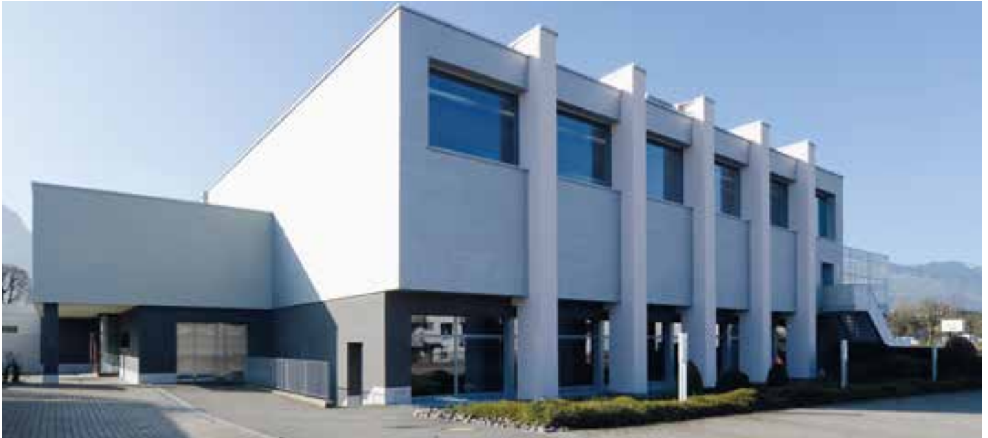
Sporttrakt der MPS Siebnen nach der Totalsanierung: trotz der 40 Jahre alten Bausubstanz ein zeitloses, modernes Gebäude.
