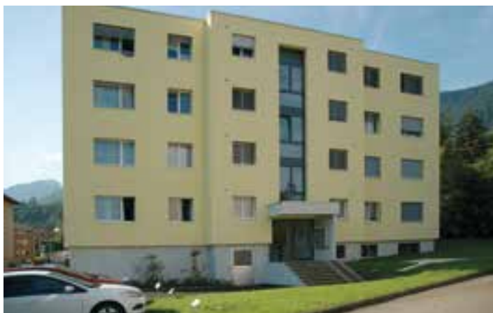
Das Mehrfamilienhaus nach der Renovation ist nun auch ästhetisch aufgewertet.
