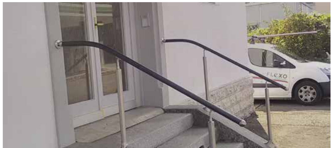
Beidseitiger Aussenhandlauf vor einem Bürogebäude
