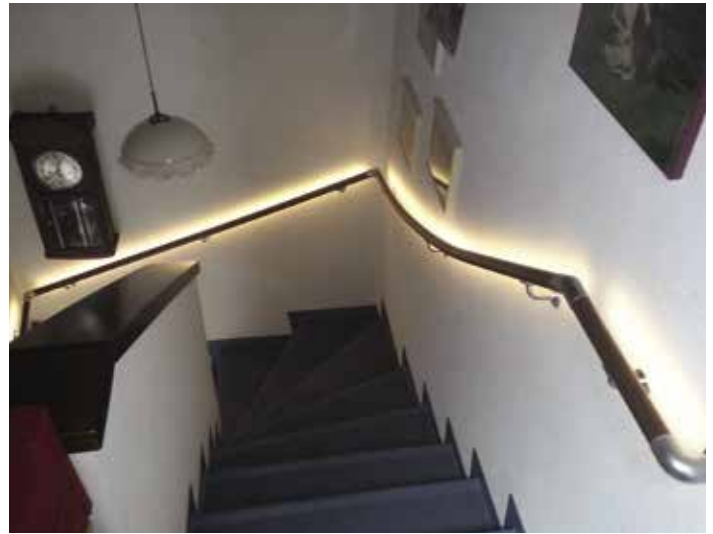
durchlaufender Handlauf mit Licht, wandseitig, wo die Stufen breiter und sicherer sind
