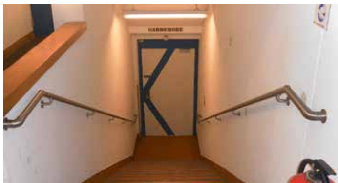
Gebäude mit Publikumsverkehr mit beidseitigem Handlauf
