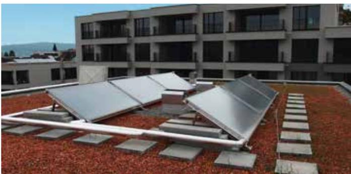
WTS-F2 Solar-Kollektoren auf den Flachdächer sorgen für hohe Solarerträge (Bild: Haus A).
