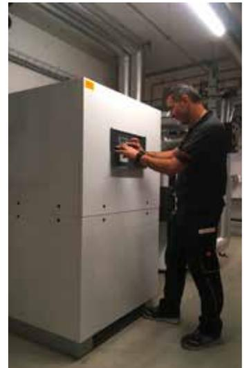
Letzte Einstellungen der Sole/Wasser-Wärmepumpe WWP S 50 ID (Heizleistung: 52 kW) im Haus F.
