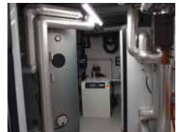
Weishaupt Sole/Wasser-Wärmepumpe WWP S 18 ID (Heizleistung: 17,5 kW) mit Energie- und Trinkwasserspeicher im Haus A.
