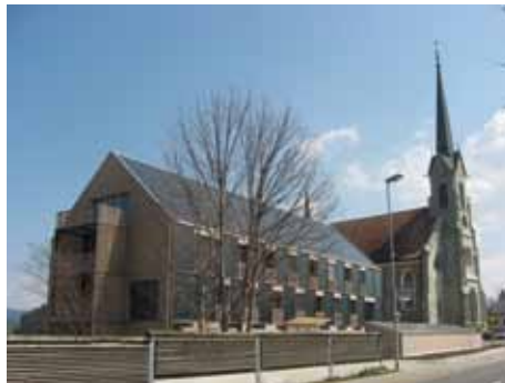
Kraftwerk B, Bennau (Foto: Grab Architekten AG, Altendorf).
