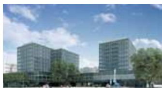
Der Neumarkt in St. Gallen erhält eine neue, zeitgemässe Fassade.
