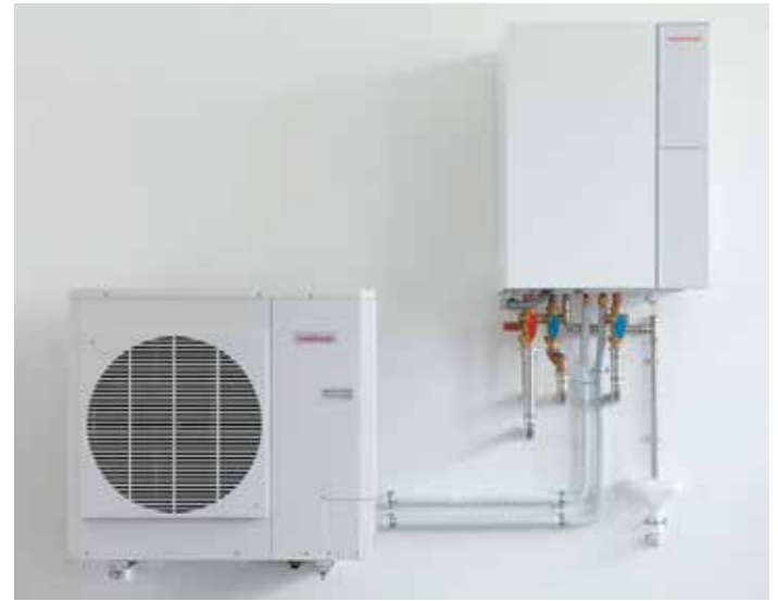
Die 7 kW Splitwärmepumpe mit Aussen- und Innengerät (Hydraulikeinheit)
