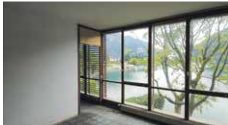
Umbau eines denkmalgeschützten Hauses (Foto: Kristina Kröger).
