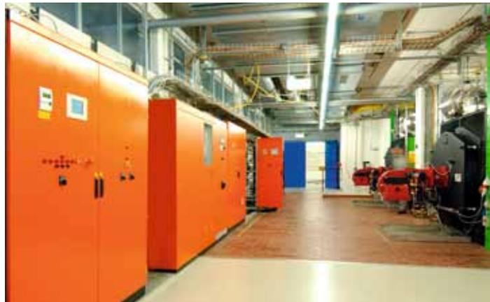
Sanierung Triemli: Heisswasserzentrale mit zwei multiflam®-Zweistoffbrennern RGL40/2-A 3LN mit Feuerungsmanager. Links im Bild die übergeordnete Leittechnik, die mit dem WH-Feuerungsmanager verbunden ist.
