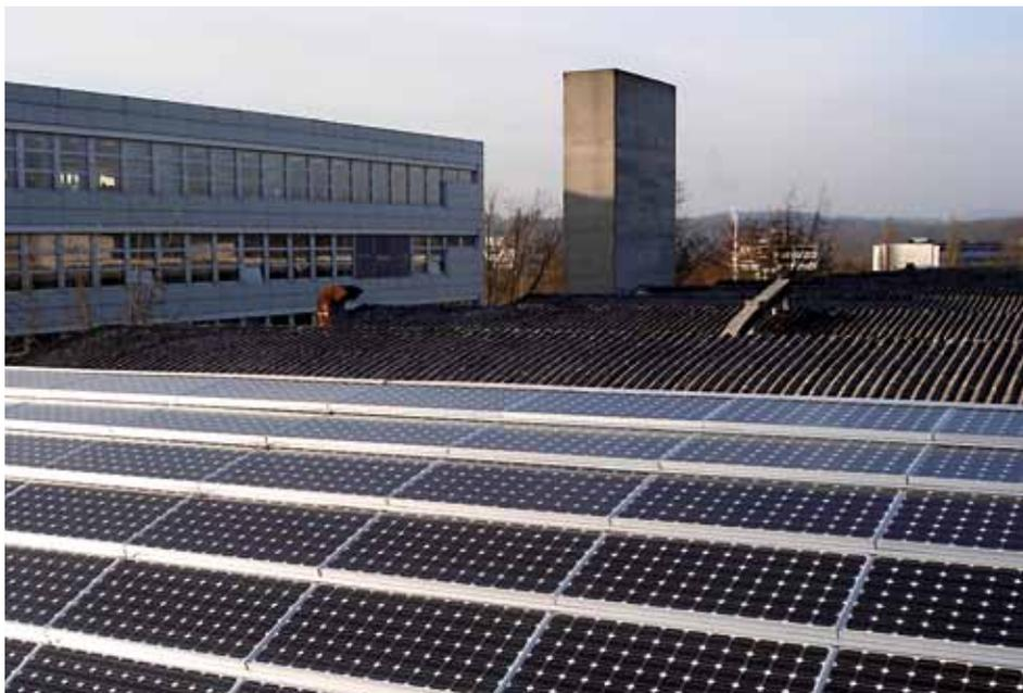
Solarsynergien nutzen und Kosten sparen: Einsparung konventioneller Dacheindeckung (im Hintergrund) durch Substitution mit ziegeldichtem Solarkraftwerk – Alstom, Birr.
