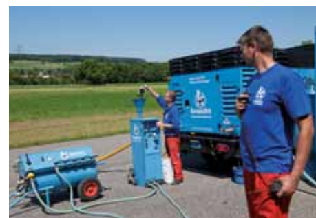
Sanierer im Einsatz.
