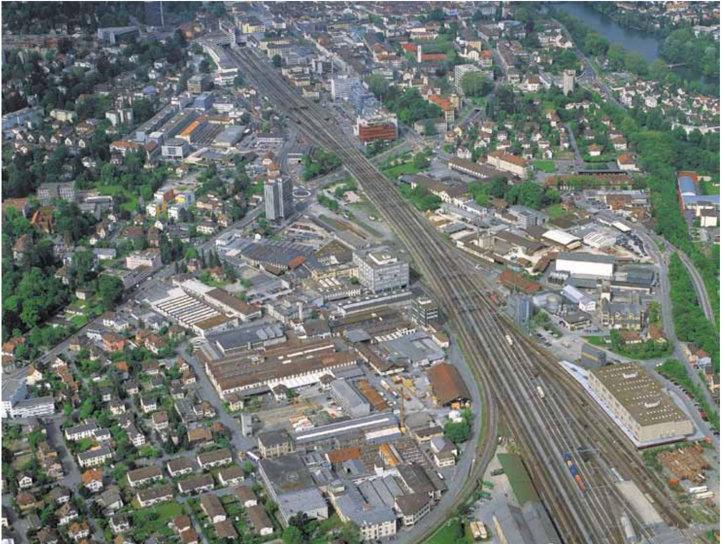
Die Entwicklungsgebiete Torfeld Süd (im Vordergrund unten), Torfeld Nord (rechts der Bahngeleise) und Bahnhof Süd (links der Bahngeleise oben). Rechts oben ist auf dieser Aufnahme noch der alte Bahnhof zu sehen, der inzwischen dem Neubau gewichen ist (Foto: z. V. g. Mobimo).
