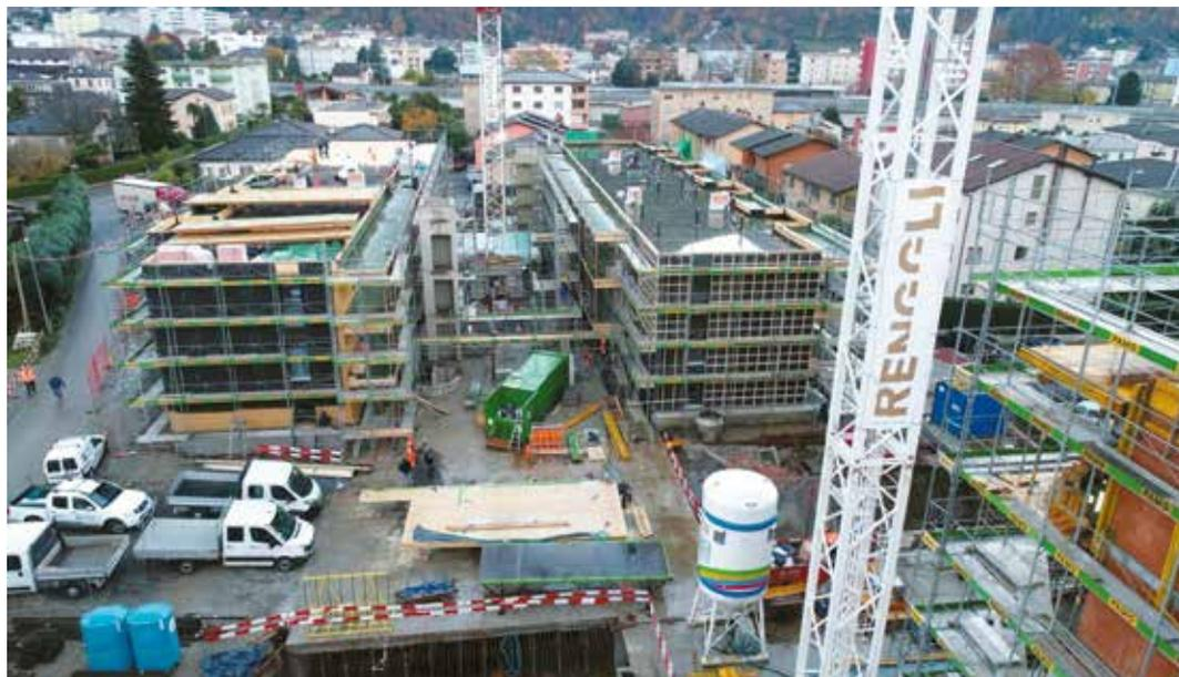
Nutzen – denn die beiden Gebäude wurden dank einem hohen Vorfertigungsgrad der Holzbaulemente innerhalb von nur zwei Monaten aufgerichtet. Eine relativ kurze Bauzeit bedeutet frühere Rendite des Objektes.
