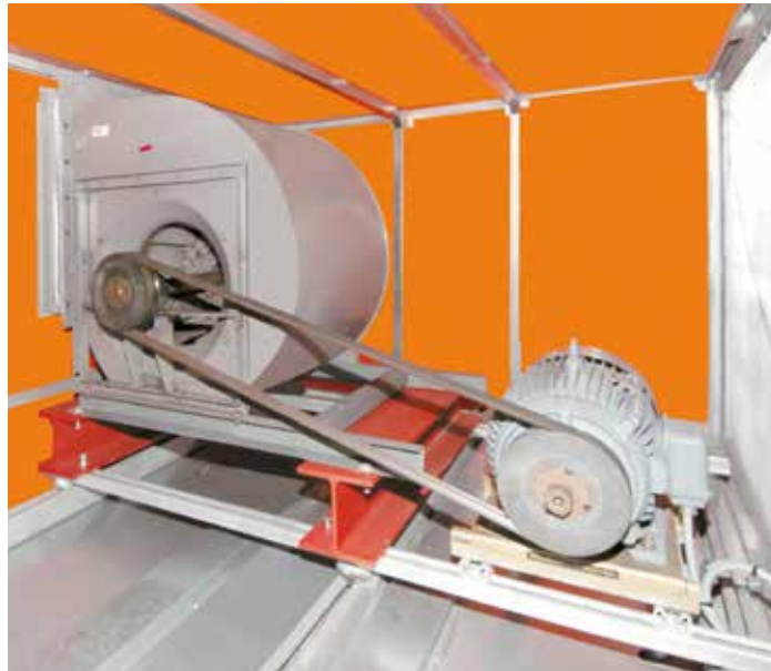
Bild 2: Vorher: Ventilator im Monobloc, Baujahr 1982. Fördervolumen 25 000 m 3 /h
