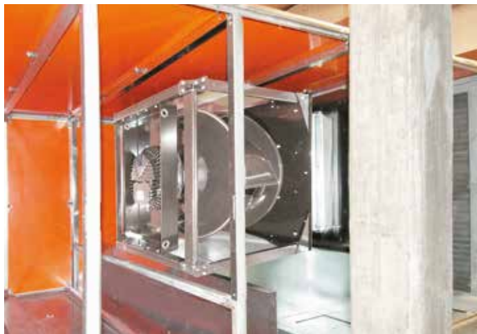
Bild 3: Retrofit: Gleiches Gehäuse von 1982, neu mit EC-Ventilator RadiPac und eingebauten Druckwänden.
