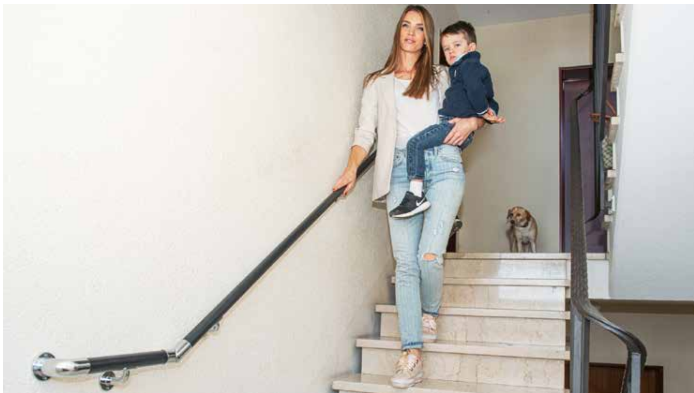
Ein beidseitiger Handlauf im Treppenhaus sollte selbstverständlich sein – für mehr Sicherheit für Gross und Klein!
