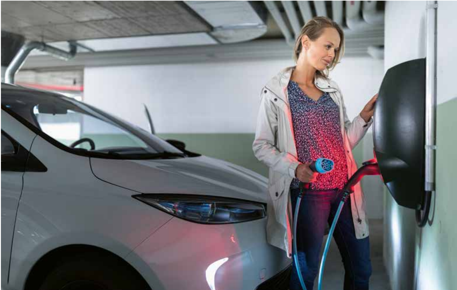
Den Lademöglichkeiten zuhause – im Wohneigentum und in Mietliegenschaften – kommt bei der Elektrifizierung des Individualverkehrs eine Schlüsselrolle zu. BILD: 123RF.COM
