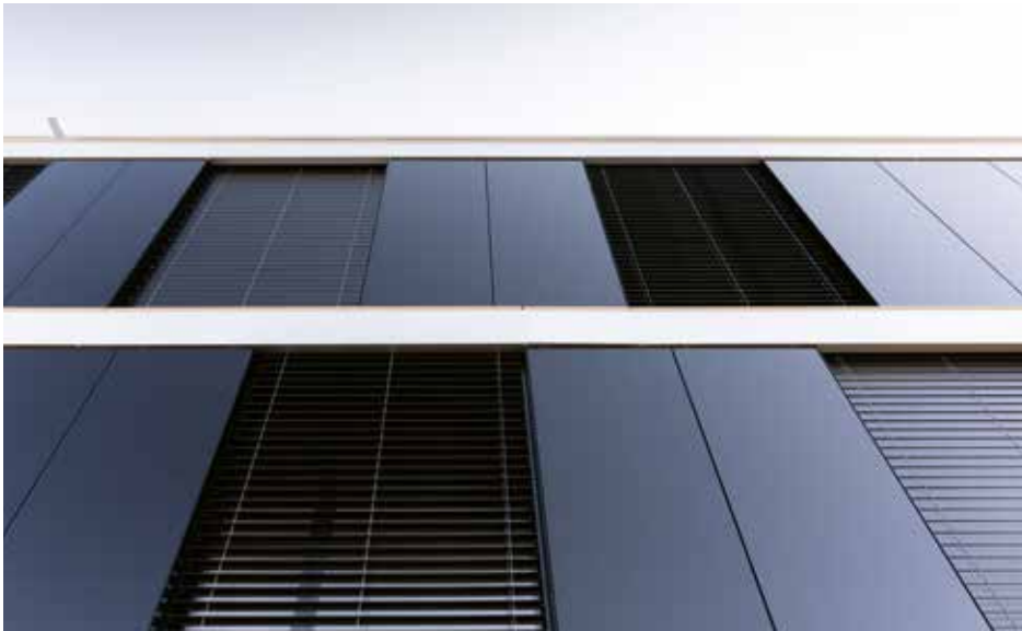
Die PV-Elemente sind auf die Unterkonstruktion montiert. Mit der hinterlüfteten Fassade konnte die Dämmstärke reduziert werden.
