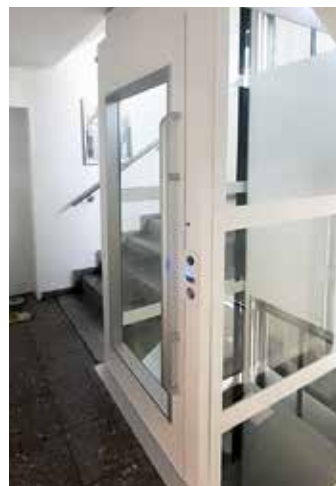
...nach dem Einbau des Liftes
