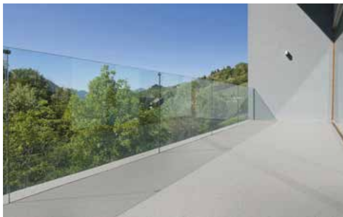
Wo die Zeit drängt: Alsan SolaFloor PMMA für den schnellen Einbau.
