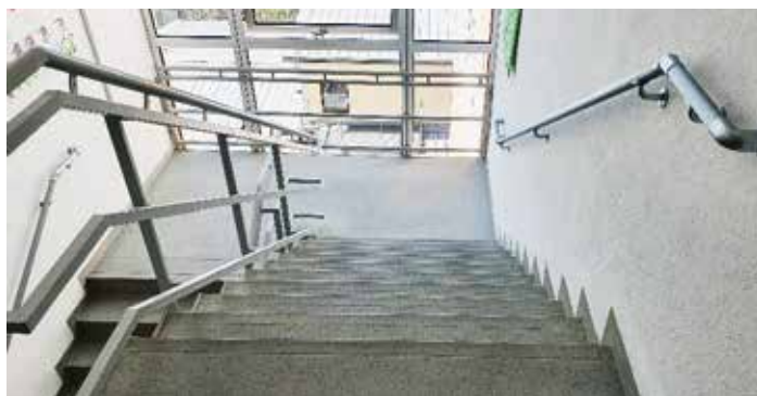
Beidseitiger Handlauf in einer Wohnanlage
